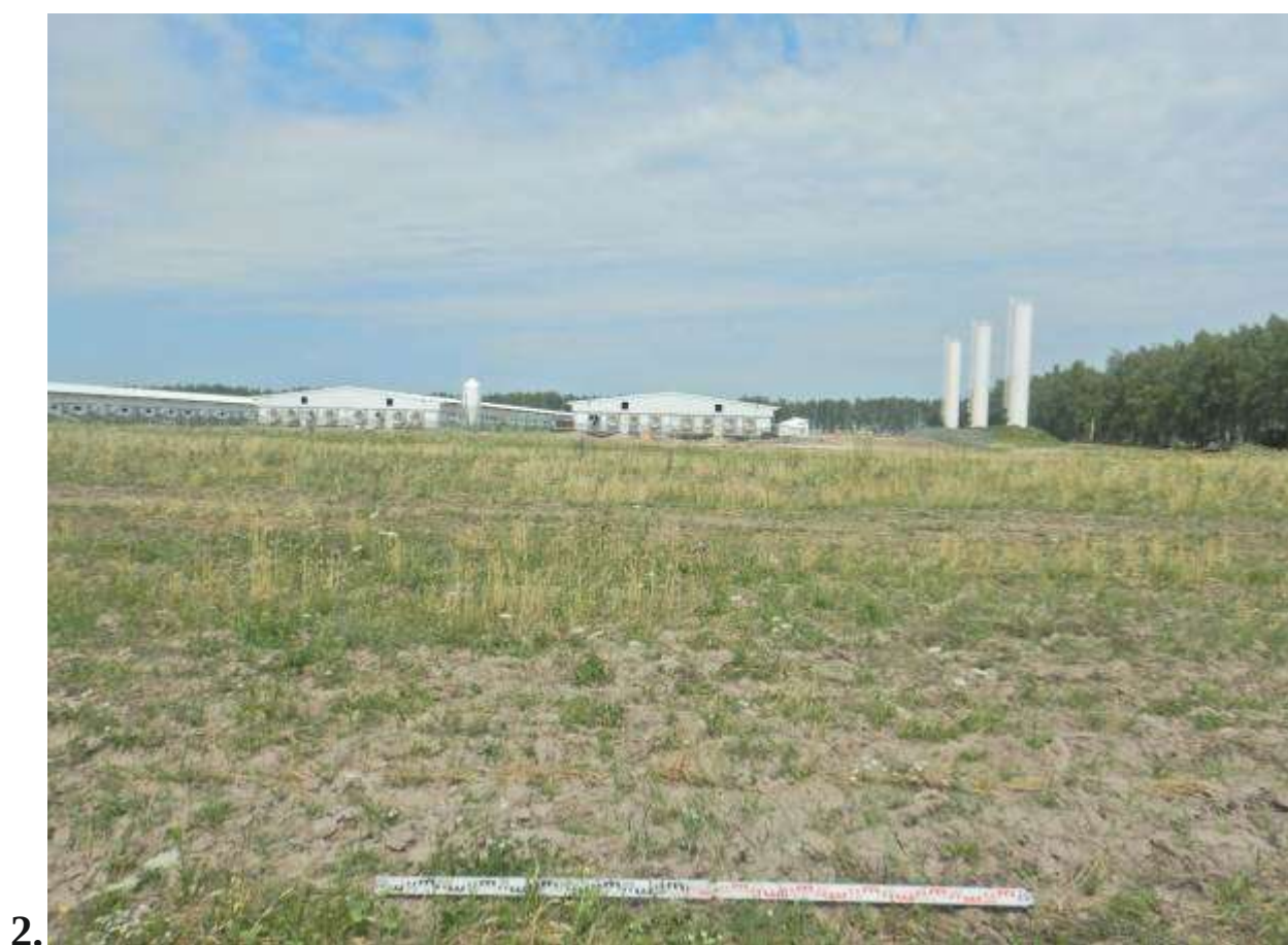
Илл. 11. Брянская область. Севский район. С. Сенное. 2020 год. Обследованный участок. 1 - вид с Ю (точка фотофиксации №5); 2 - вид с Ю (точка фотофиксации №6).
